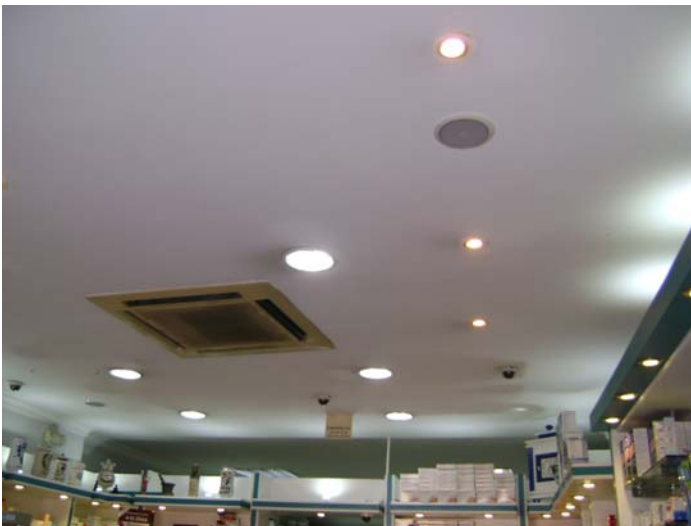
Vista de los down light led instalados
